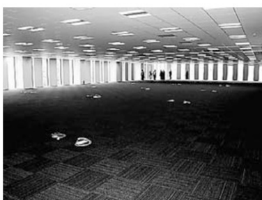
ビル6階のオフィススペース。柱がなく開放的な空間が広がる
