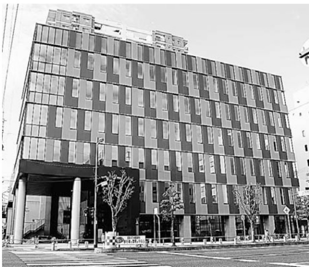
10日に竣工するラクロスビル。来年4月1日の供用開始を予定している ＝佐世保市常盤町
